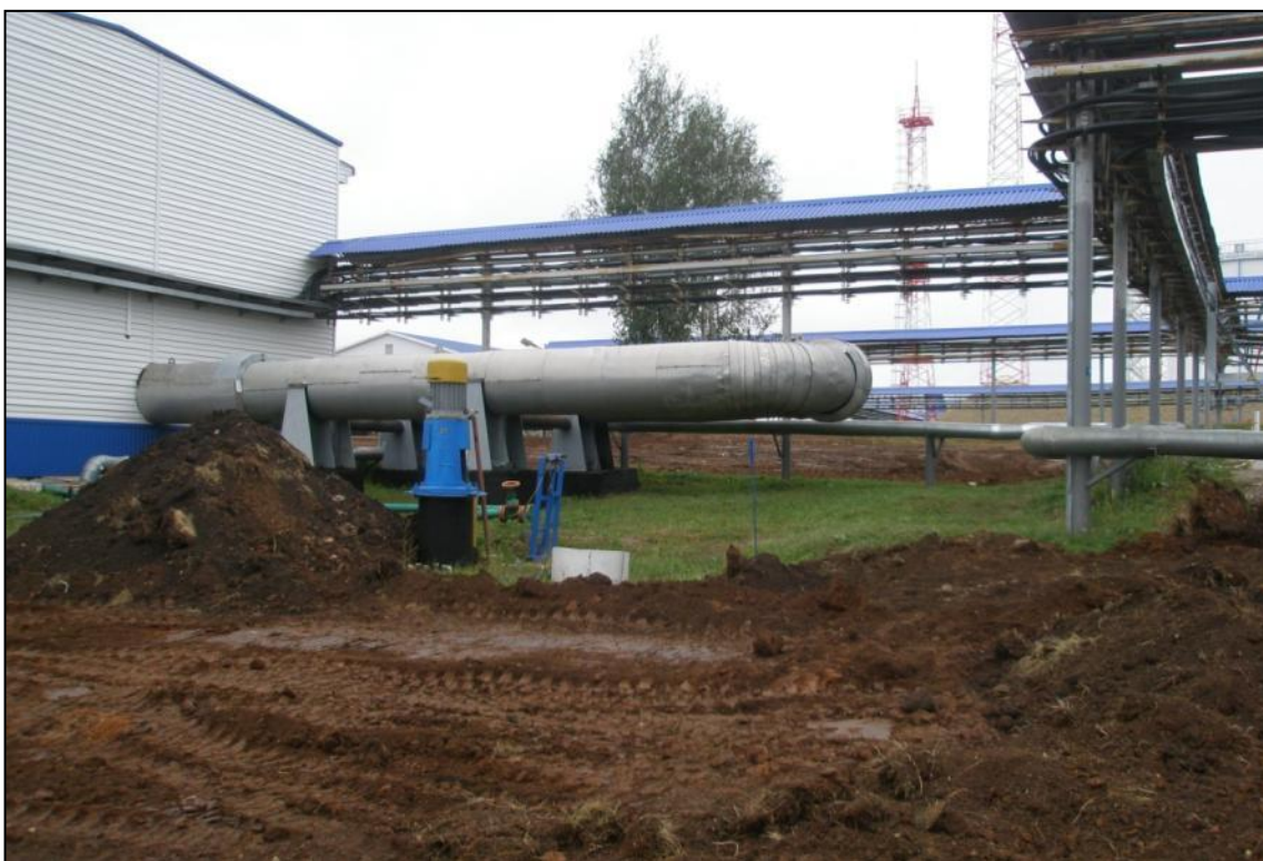
Рис.10. Объект “СИКН №917 НПС “Азнакаево”, АРНУ. Реконструкция” в Азнакаевском муниципальном районе Республики Татарстан. Прокладка сетей по существующей эстакаде. Вид с ССЗ.
