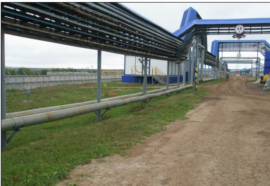
Рис.8. Объект “СИКН №917 НПС “Азнакаево”, АРНУ. Реконструкция” в Азнакаевском муниципальном районе Республики Татарстан. Прокладка сетей по существующей эстакаде. Вид с ЗСЗ.
